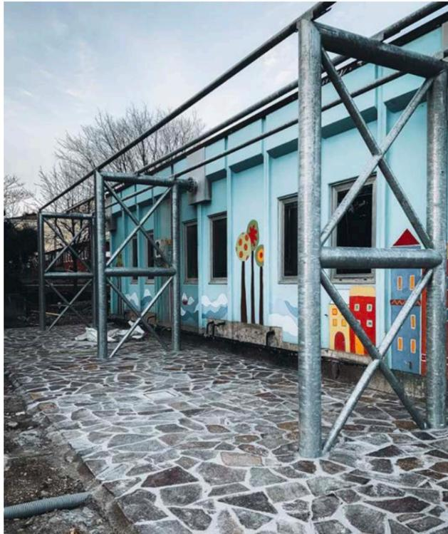
Struttura anti-sismica, Asilo Desenzano del Garda (BS)
